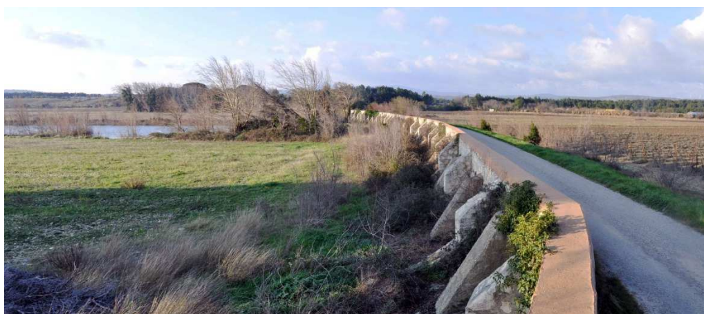
Photographie 57 : La digue de l'Espina avec un exhaussement visible à droite
