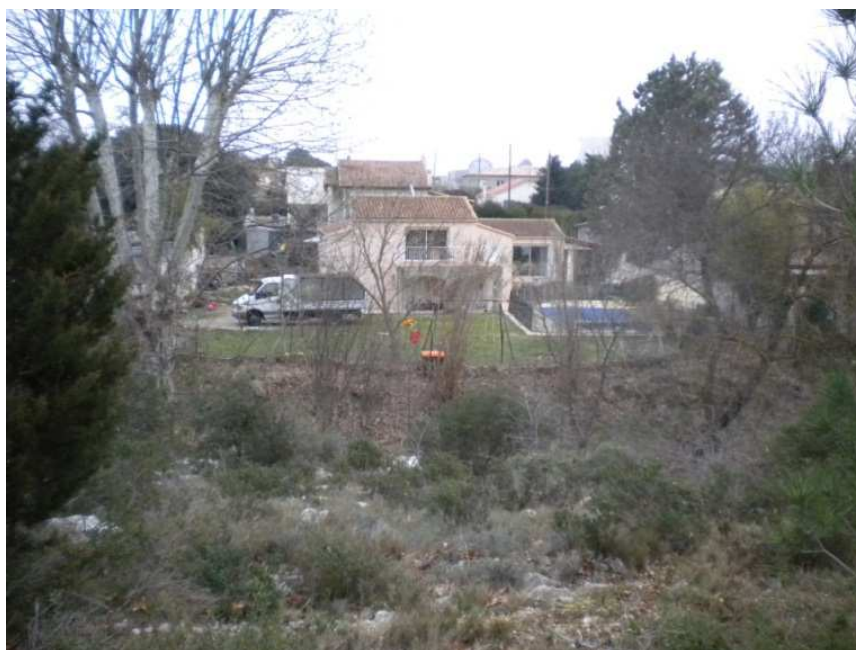
Photographie 95 : maison en limite de zone inondable à Castries
