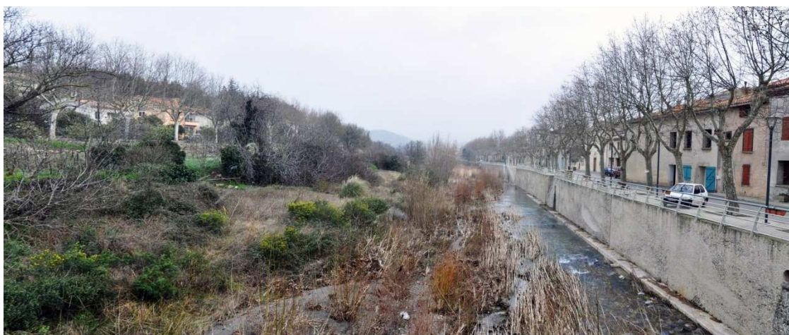
Photographie 37 : La Berre à Cascastel : maisons à droite ont subi plus d'un mètre d'eau en 1999
