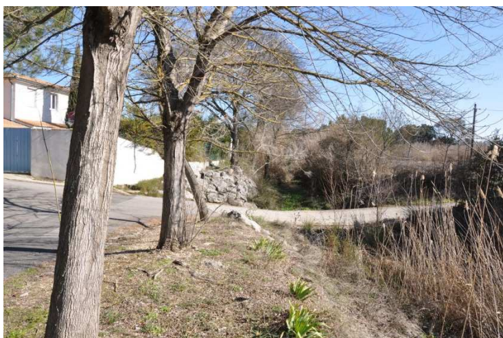
Photographie 104 : maison en zone inondable à Sussargues
