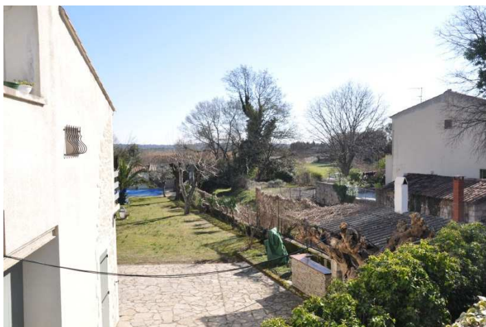
Photographie 103 : Bâtiments en zone inondable à Saint-Drézéry
