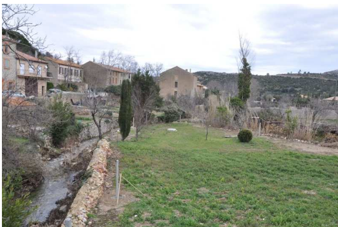
Photographie 65 : Bâtiments en zone inondable dans la ville de Feuilla
