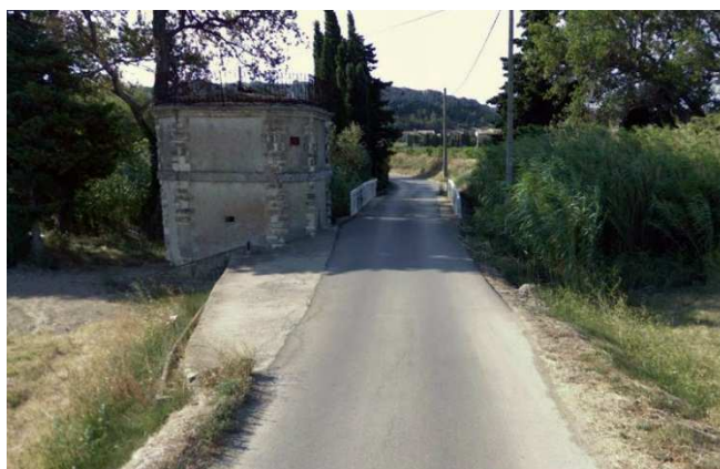
Photographie 62 : Station de pompage en zone inondable à Roquefort-des-Corbières
