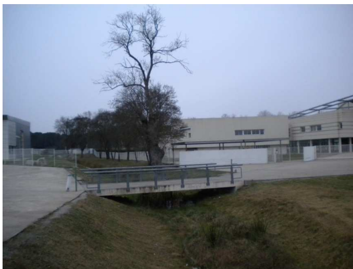
Photographie 85 : le collège de Jacou en zone inondable
