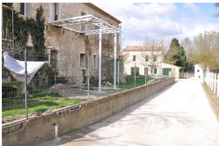
Photographie 56 : Bâtiments en zone inondable au Hameau du Lac
