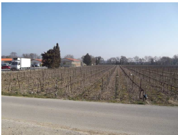
Photographie 98 : bâtiments d'Emmaüs en zone inondable
