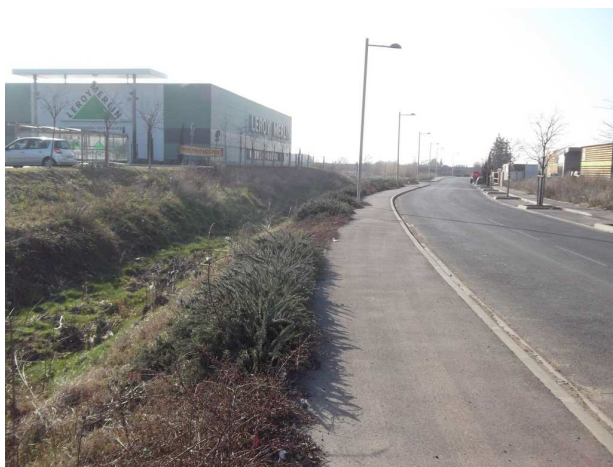
Photographie 89 : Bâtiment remblayé en rive gauche du ruisseau de la Balaurie
