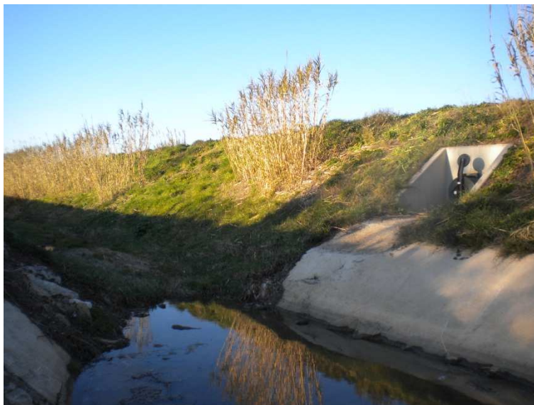
Photographie 90 : les digues du ruisseau de la Balaurie, près de Mauguio
