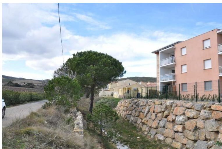
Photographie 26 : Enrochement sur le ruisseau de la Plaine
