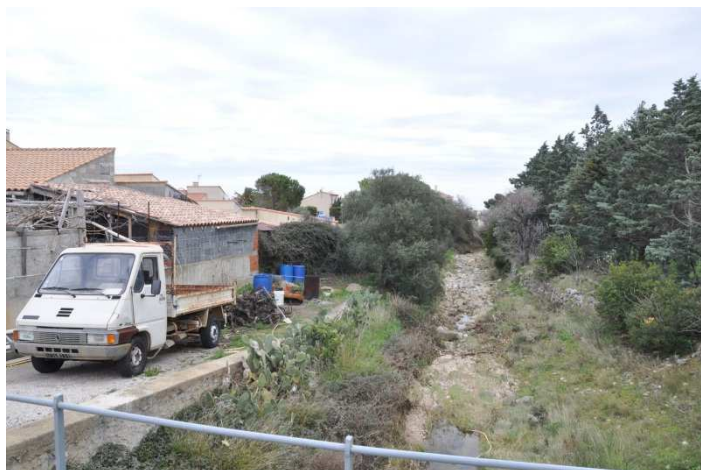
Photographie 67 : Bâtiment dans le lit majeur du ruisseau de l'Arène à Caves
