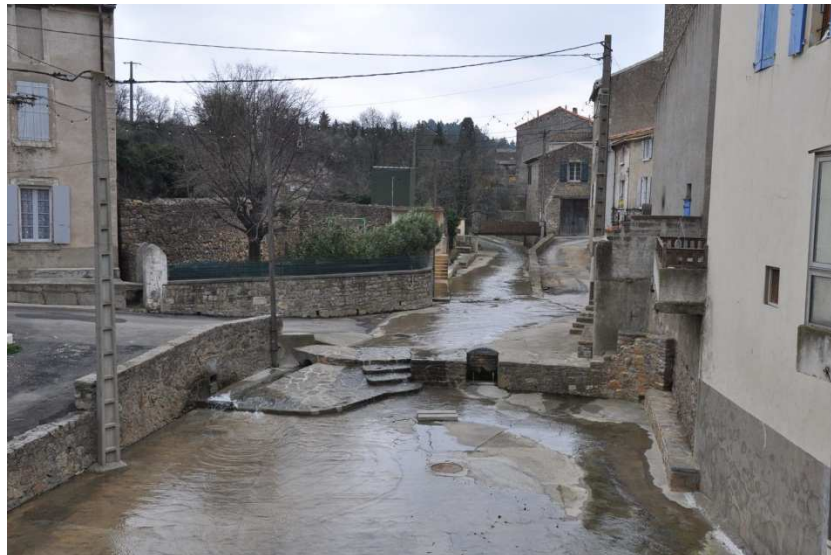
Photographie 46 : Le ruisseau Saint-François aménagé en rue à Saint-Jean-de-Barrou
