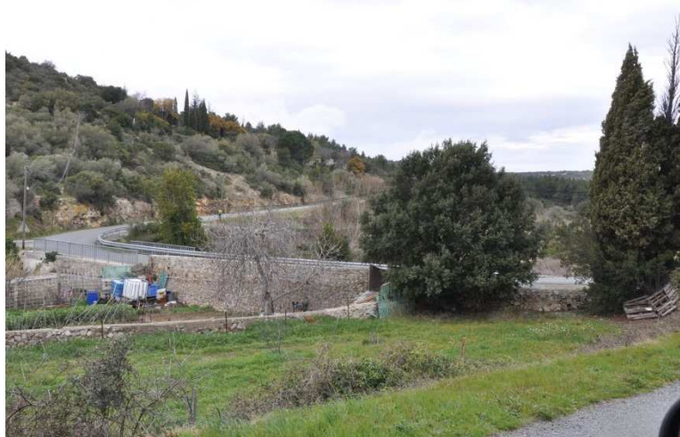
Photographie 66 : Remblai routier dans le lit majeur du ruisseau de l'Arène
