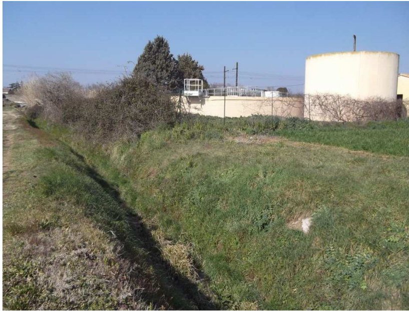
Photographie 101 : station d'épuration en zone inondable au sud de Baillargues
