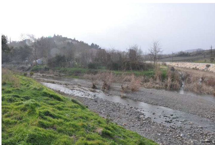
Photographie 40 : Bâtiments en zone inondable à la confluence entre la Berre et le ruisseau de Courtals
